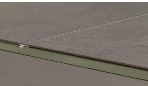
Coupez sur mesure. Au niveau du périmètre, veillez à maintenir un espace d'environ 5 mm avec les parois. Ce joint périphérique sera ensuite recouvert par une plinthe ou bien rempli avec du silicone, comme un joint normal.
