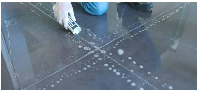
FILLER FAST, mastic en silicone monocomposant à réticulation acétique sans solvants, se présente comme une pâte thixotropique facilement applicable à l'horizontale, qui réticule avec l'humidité de l'air à température ambiante, devenant ainsi un produit élastique avec les propriétés suivantes:
