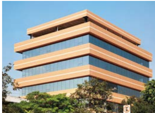
Jurubatuba Building, São Paulo, Brésil / Architectes : Valéria Taurino, São Paulo/SP, Brésil
