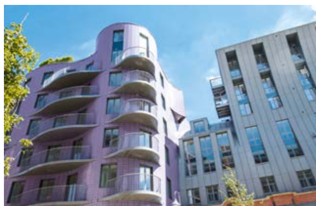
Apartment Building « Islington Square, Studd Street », Londres, Grande-Bretagne / Architecte : CZWG architects, Londres / Année : 2020 / Photo : John Cave
