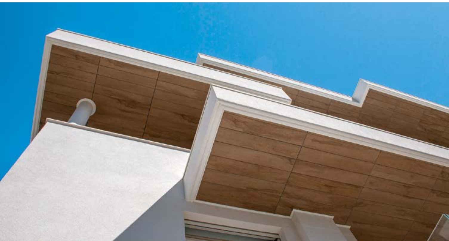
Edificio Residenziale Via degli Schiavoni, Fano, Italie / Architecte : Studio Zandri Via de Borgogelli / Année : 2019 / Photo : VM Group
