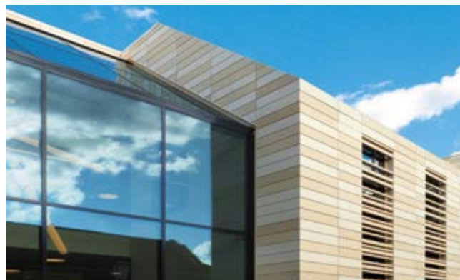
Raiffeisen Forum, Mödling, Autriche / Architecte : arge x42 / Année : 2014 / Photo : Rich Hiebl
