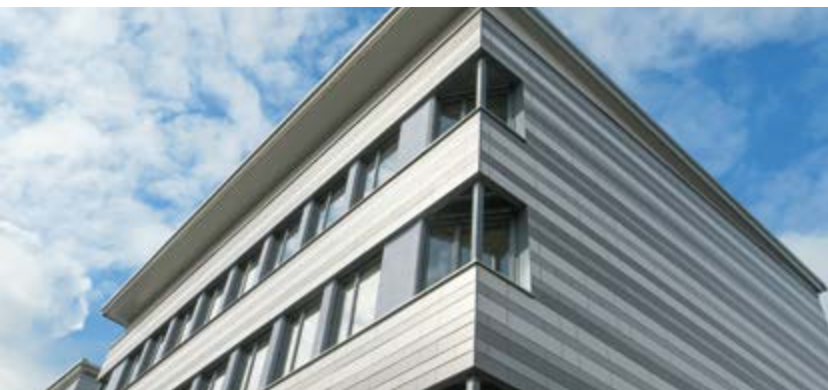
Naabtal-Realschule (école), Nabburg, Allemagne / Architecte : Architekturbüro Schönberger / Année : 2016 / Photo : Atelier Bürger
