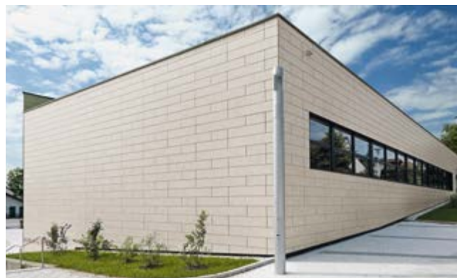
KUBEZ (Kultur- und Begegnungszentrum), Dietach, Autriche / Architecte : Team M Architekten ZT GesmbH / Année : 2018 / Photo : Roland Reuter, Absam
