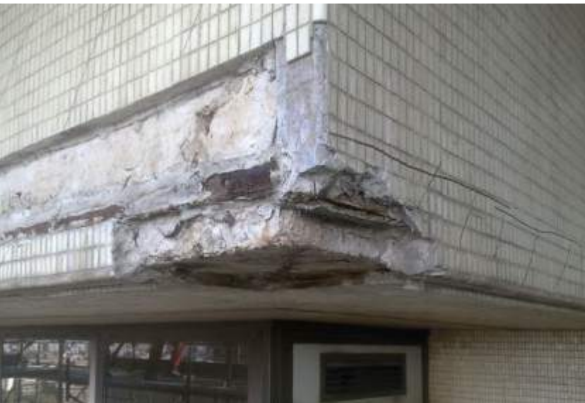
L'état avant la rénovation
