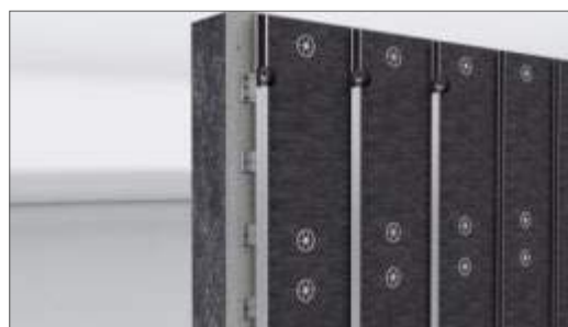
Coller la bande de joint sur les profilés porteurs verticaux.
