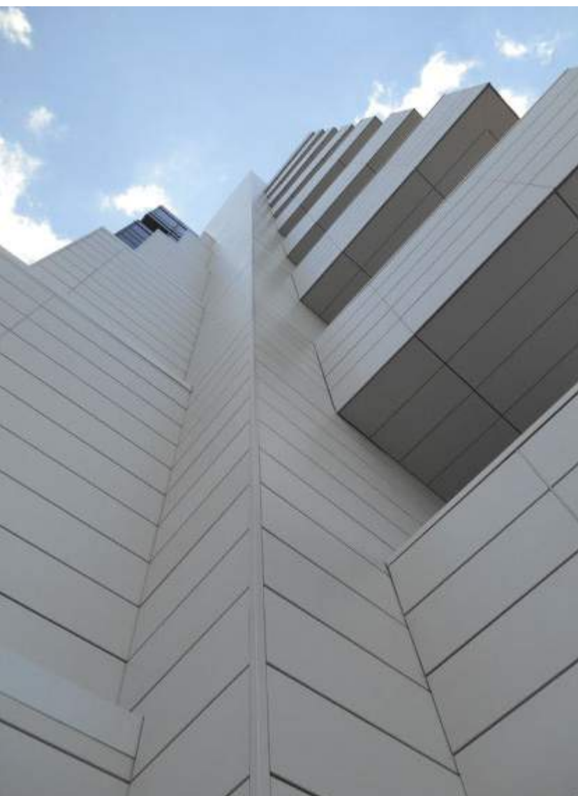
La nouvelle enveloppe du bâtiment
