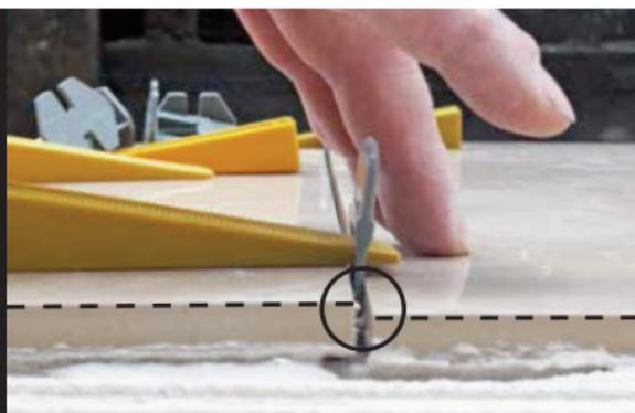
Les tuiles rectifiées de grands formats exigent plus de précision à la pose. Le système de nivellement NIVO est conçu pour faciliter le travail de l'installateur et améliorer la qualité de l'installation autant au niveau de la modularité que de l'ondulation des tuiles.
